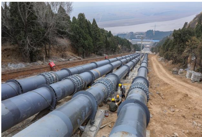
图 1 项目工地一角
